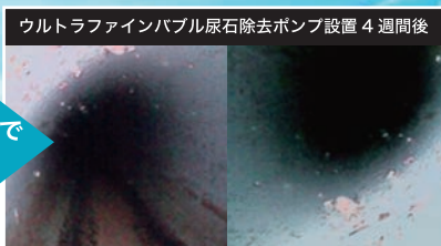
ウルトラファインバブル尿石除去ポンプ設置 4 週間後
