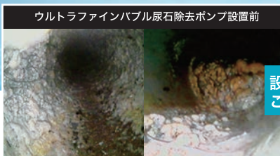
ウルトラファインバブル尿石除去ポンプ設置前
